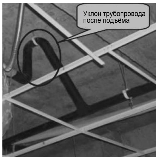
Рисунок 3-6.7: Изображение дренажного трубопровода с подъемом
